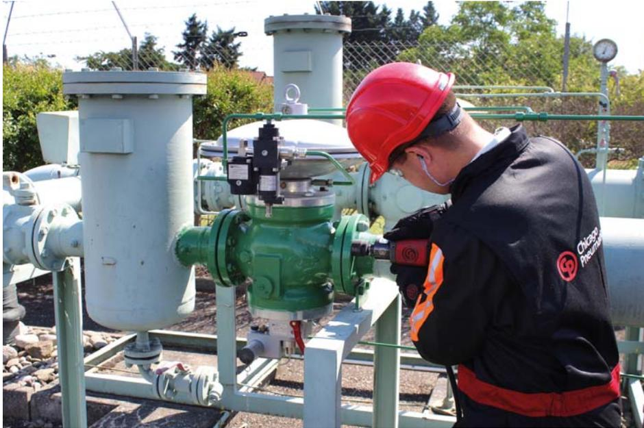
*In explosionsgefährdeten Bereichen etwa von Raffinerien darf nur mit geeigneten Werkzeugen gearbeitet werden. Für die Wartung und Reparatur in derartigen Umgebungen stellt Chicago Pneumatic zahlreiche Druckluft-Schlagschrauber und -Bohrmaschinen mit ATEX-Zertifikat zur Verfügung. Im Bild wird gerade ein Gas-Druckregelgerät mit einem Schlagschrauber des Typs CP6748EX gewartet. (Bild: Chicago Pneumatic)*
