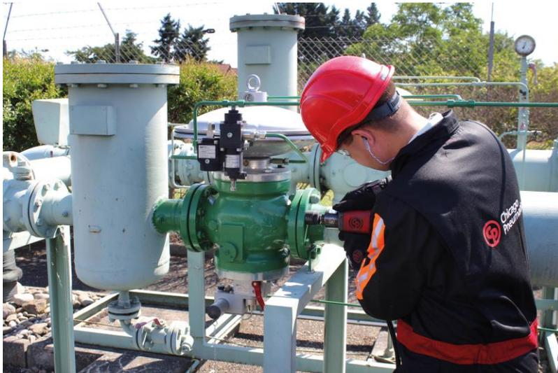
*Wartungs- und Reparaturarbeiten dürfen in explosionsgefährdeten Bereichen etwa von Raffinerien nur mit dafür geeigneten Werkzeugen durchgeführt werden. Für Tätigkeiten in derartigen Umgebungen stellt Chicago Pneumatic zahlreiche Druckluft-Schlagschrauber und -Bohrmaschinen mit ATEX-Zertifikat zur Verfügung. Im Bild wird gerade mit einem Schlagschrauber des Typs CP6748EX ein Gas-Druckregelgerät gewartet. (Bild: Chicago Pneumatic)*
