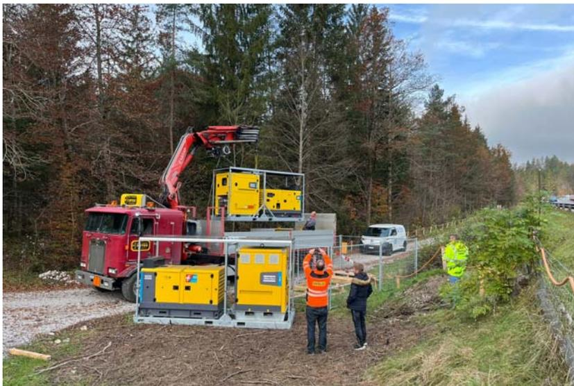
*Bei Walo Bertschinger sind aktuell zwei Hybridspeicher im Einsatz, die elektrische Pumpen mit Strom versorgen. Die Anlagen werden für den Bau eines längeren Autobahnabschnitts zwischen Thun und Spiez in der Schweiz benötigt. Hier führen große Teile der Strecke durch Waldgebiet, weshalb ein konventioneller Stromanschluss nicht verfügbar war. Mit den Pumpen wird Regenwasser von der Baustelle abgeleitet. (Bild: Atlas Copco)*
