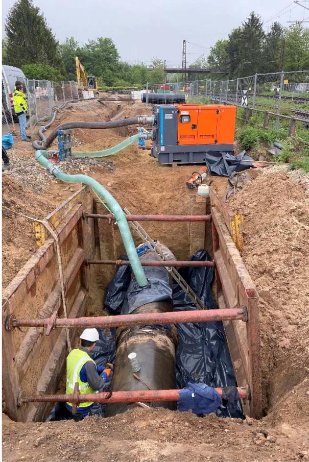
*Die rot-graue Entwässerungspumpe des Typs PAS 150MF von Atlas Copco konnte kurzfristig als Miet-Aggregat herbeigeschafft werden. Sie saugt trocken an und eignete sich bestens zum Leerpumpen dieses Teilstücks einer Trinkwasser-Transportleitung. (Bild: Atlas Copco/Keil & Purkl)*
