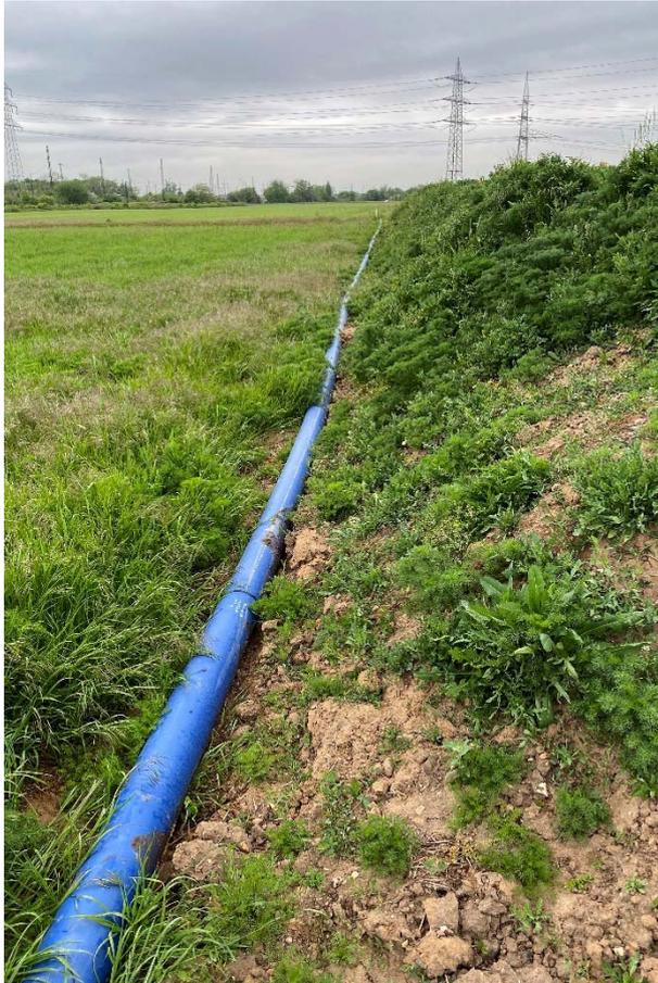
*Diese zur Pumpe passenden Schnellkupplungsrohrleitungen wurden von der Hettmansperger Spezialtiefbau GmbH in Karlsruhe geliefert. Über die SK-Rohre mit ihrem Durchmesser von DN 150 wurden die 600 m<sup>3</sup> Wasser in ein Sammelbecken gefördert. (Bild: Atlas Copco/Keil & Purkl)*
