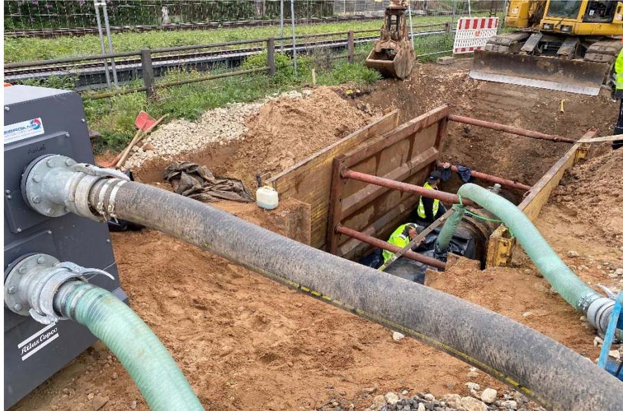
*Das PAS-Diesel-Pump-Aggregat (links) ist auf hohe Leistung ausgelegt und überwindet auch Saughöhen von mehreren Metern problemlos, weil die Saugleitung schnell entlüftet wird und das Pumpen sofort beginnen kann. (Bild: Atlas Copco/Keil & Purkl)*
