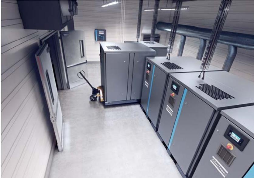
*Die drehzahlregelten Schraubengebläse des Typs ZS 4 VSD<sup>+</sup> verdichten die Luft mit ihrem Permanentmagnetmotor der IE5-Klasse um rund 10 % effizienter als die Vorgängergeneration. Und sie benötigen weniger Stellfläche. (Bild: Atlas Copco)*
