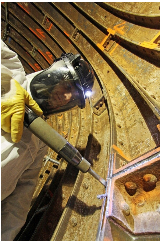
In de oostelijke St.-Pauli-Elbetunnel moet 15000 meter oude loodafdichting vernieuwd worden; bijna de helft van de hele afdichtingslengte. Er wordt gesaneerd met behulp van PRO-hakhamers van Atlas Copco Tools. (Foto: Atlas Copco Tools)
