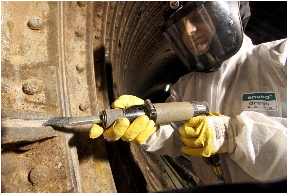
Met perslucht-hakhamers van het type PRO P2550 van Atlas Copco Tools worden de gietstalen ringen van de Elbetunnel gerenoveerd. (Foto: Atlas Copco Tools)
